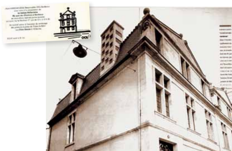
Bijou du quai des Chartrons, cet immeuble de 1680 abritait un magasin d'articles de sport et un consulat à l'étage. La difficulté principale a été de déterminer quel ornement poser sur les potelets (pots de feu ou boules ? de quel diamètre ?).
